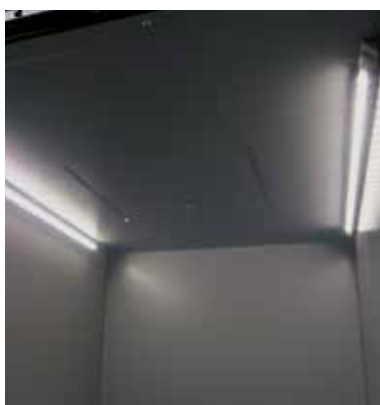
Illuminazione Cabina con barre LED
